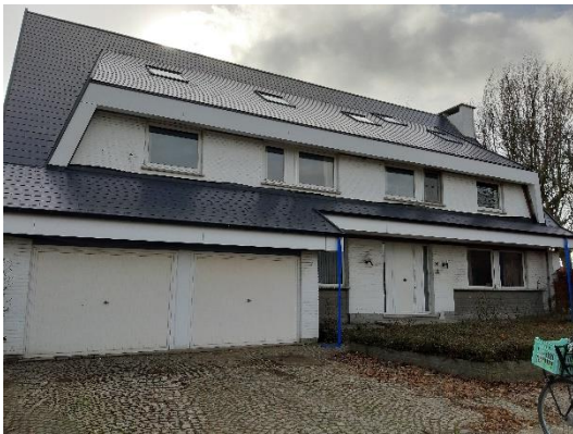
Te renoveren huis Wilgenstraat, jan. 2021
